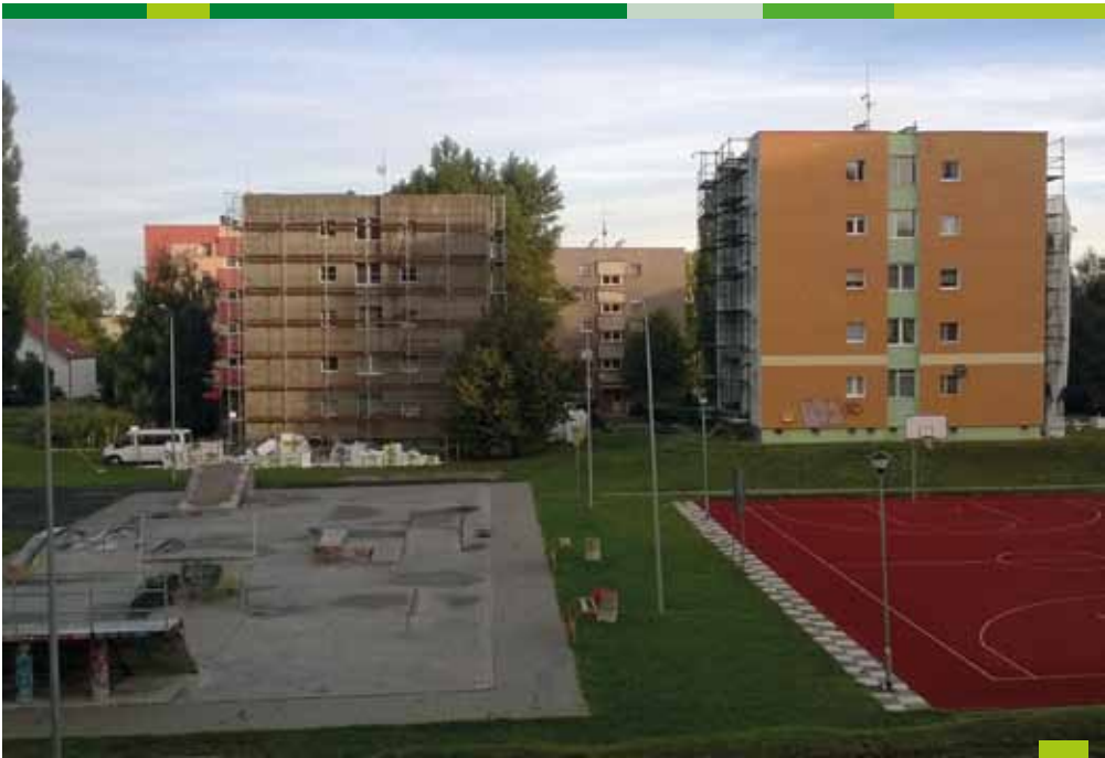
Ryc. 48. Prace termomodernizacyjne są częstym widokiem na osiedlach mieszkaniowych. Niestety niosą ze sobą duże zagrożenia dla ptaków gniazdujących w obrębie budynków (fot. M. Bocheński)
